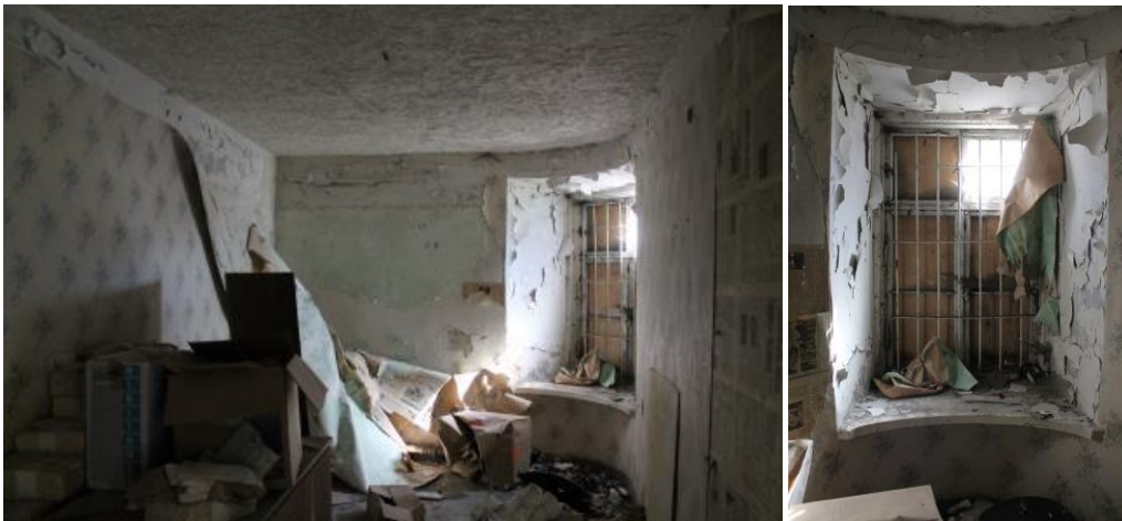
Fotod 36 ja 37. Vaade ruumi nr 12 ümarale välisnurgale, kus asub seina sisse ehitatud aknalauaga algupärane puitaken koos kinnititega.
