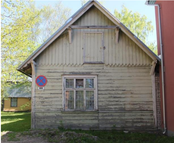
Foto 54. Vaade Staadioni tn 50 hoone kõige hiljem ehitatud hooneosa otsaseinale.
