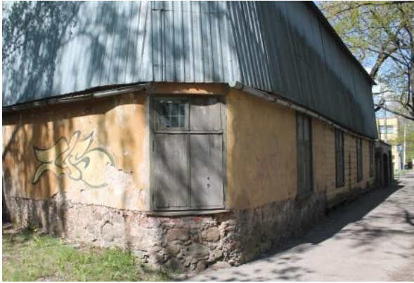
Foto 29. Hoone idanurk, mis on ainulaadselt ümar ning ühe ruumi laiuselt üle krohvitud kivist seinaga.
