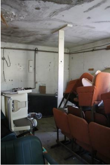
Foto 60. Vaade ruumile nr 25. Tugipost, mis hoiab lage sisse vajumast.
