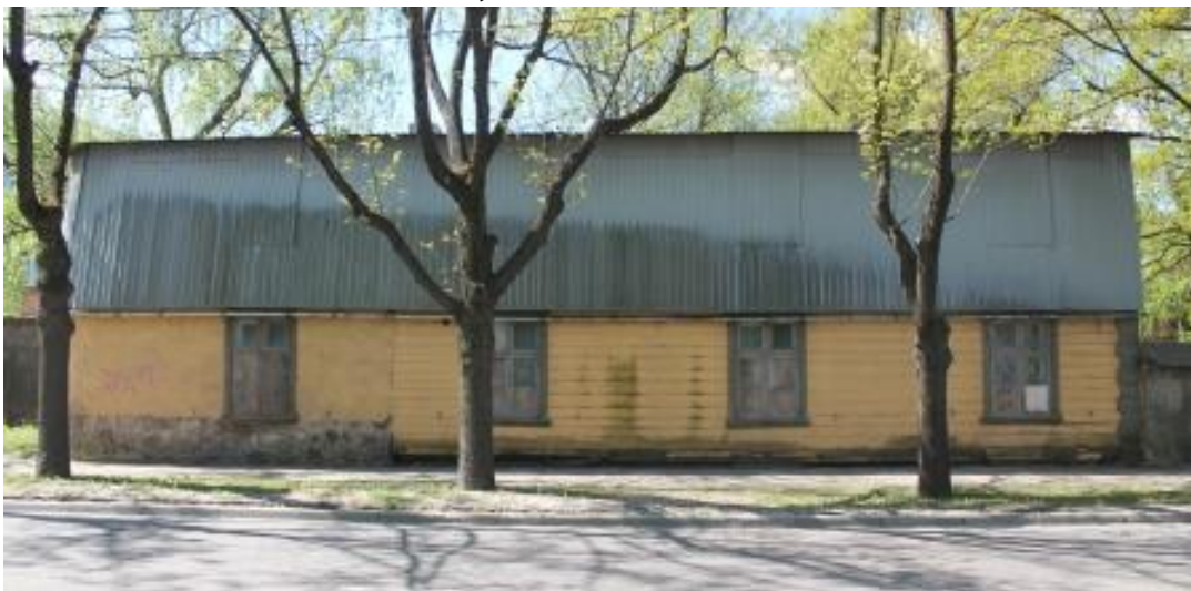
Foto 28. Hoone Staadioni tn 50 kirdepoolne külg, mis on paralleelne Puiestee tänavaga. Näha puidust ja kivist ehitatud seinte üleminek. Kõrge maakivist sokkel idapoolsel hooneosal.
