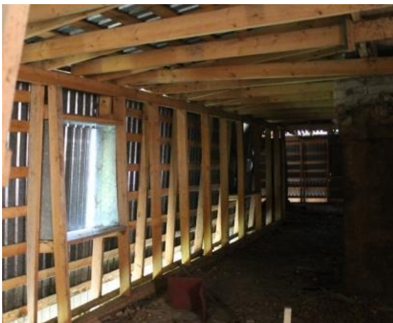
Foto 33. Katusekonstruktsiooni sisse ehitatud aknakohad.
