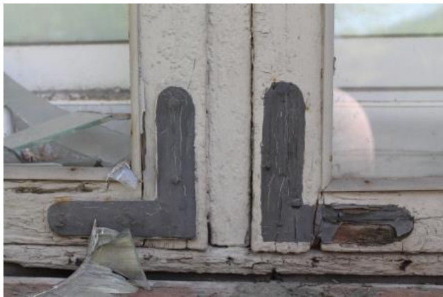
Foto 32. Viimati kasutusel olnud hooneosa remonditud aken. Ruumi 1 hoovipoolne aken. Korda tehtud nii, et olemasolevad metallosad on üle värvitud tumeda värviga ning puuduvad osad on lihtsalt juurde maalitud.
